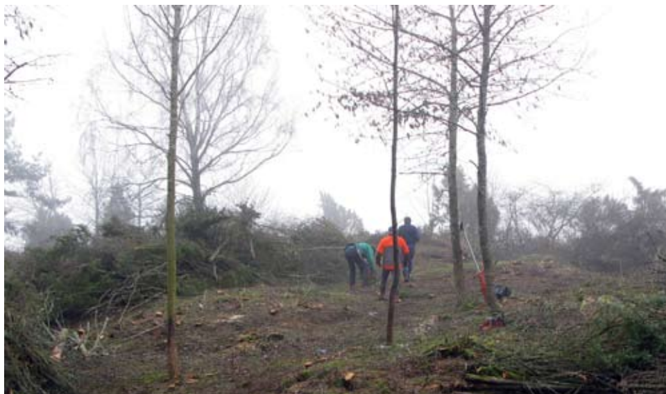
Röjningsarbete på ett gravfält i Hov, Mogata.
